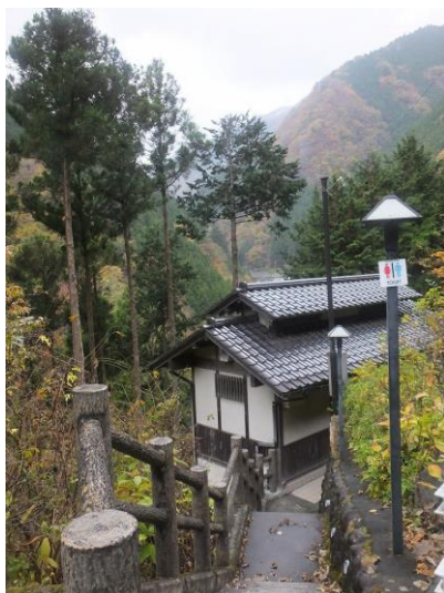
民家？ところがトイレ
